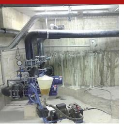
Resina poliuretanica monocomponente idroespansiva (non necessita di catalizzatore e aumenta il proprio volume iniziale di circa 3 volte), esente da solventi, ideale per sigillare, mediante iniezione, piccole e grandi infiltrazioni d'acqua nel calcestruzzo o nelle murature piene in genere. Ideale per colmare grandi vuoti e vespai interni alle murature. Reagisce con l'acqua e forma una schiuma flessibile a cellule chiuse. Sviluppato per l'applicazione in strutture umide e asciutte.
